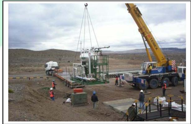
Hot taps de cañerías. Una vez armado el conjunto para el conexionado se le deberá hacer una prueba de estanqueidad, verificando en forma externa con agua jabonosa la no existencia de pérdidas. Desmontaje y traslados de equipos como ser: Tanques de Ensayos, Shelter de aire de instrumentos, Shelter control, Shelter de potencia, RTU, etc.
